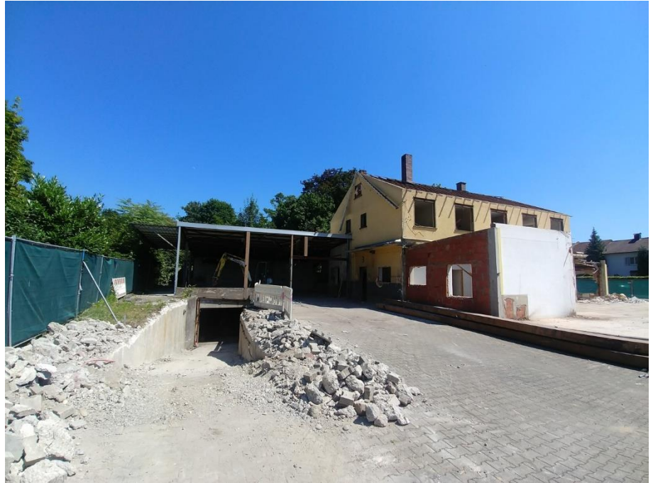
Abb. A3: Flächen im Randbereich des Plangebiets (linker Bildrand), die teilweise als Sommerlebensraum für Eidechsen geeignet wären.
