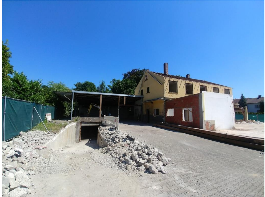
Abb. A3: Plangebiet, Blick Richtung Osten.
