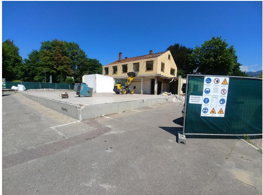
Abb. A1: Östlicher Bereich des Plangebiets mit im Abbruch befindlichem ehemaligem Autohaus inkl. Wohngebäude.
