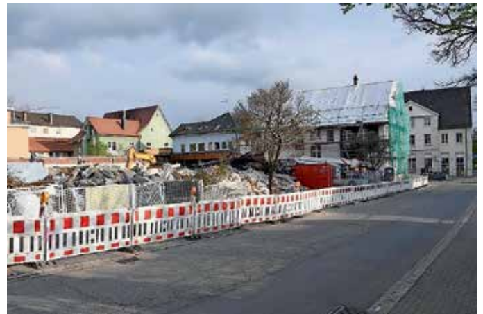
Die Überreste des Netto-Marktes und weitere Gebäude an der Werder- und an der Goethestraße werden derzeit abgerissen.
