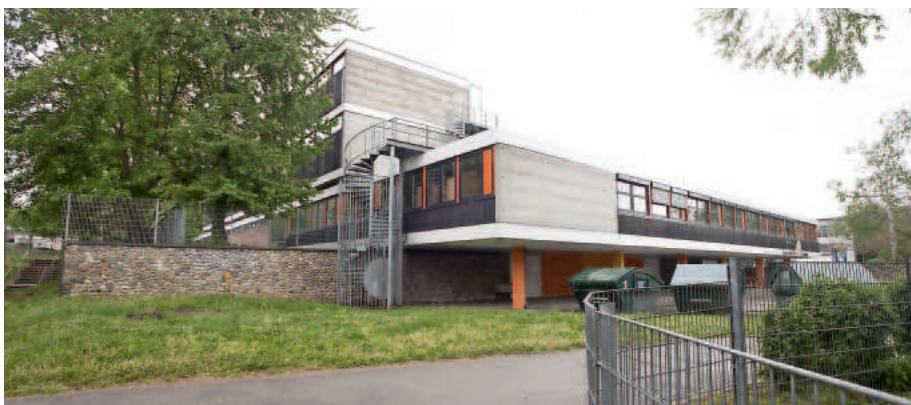
Im ersten Bauabschnitt soll die Michael-Friedrich-Wild-Grundschule einen Anbau erhalten.
