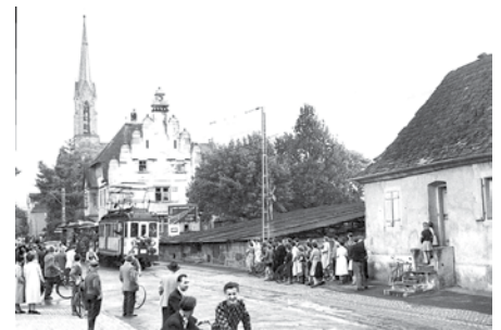
Werderstrasse mit Baulücke und „Bähnle“ (Markgräfler Museum)
