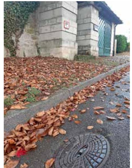
Bild 2 zeigt den ovalen Unterflurhydranten im Abstand zum Schild
