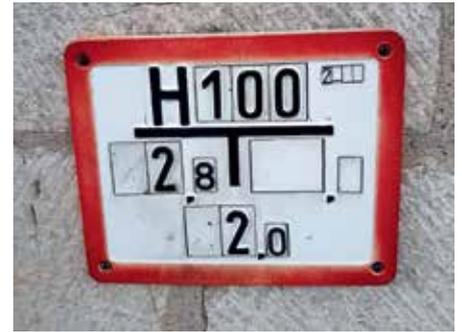
Das rotumrandete Schild zeigt den Abstand zu nächstgelegenen Unterflurhydranten zur Wasserentnahme.
